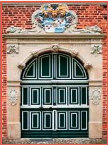
Die aufwendige Restaurierung des Rundbogenportals ist abgeschlossen. Ein Sockel und ein auf der Höhe des Kämpfers verlaufendes Gesims gliedern die Sandsteingewände, die unterhalb des Wappens durch ein mehrfach gestaffeltes, horizontal verlaufendes Profil zusammengefasst sind. Die Halbkreisarchivolte schmückt figürliche Darstellungen und verzierte Keilsteine.
