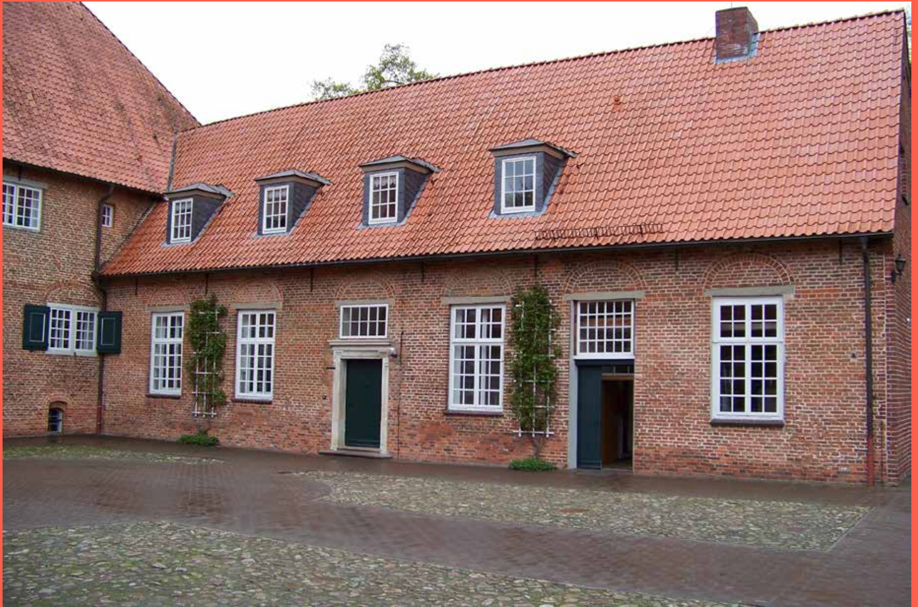
Sanierung des Westflügels
